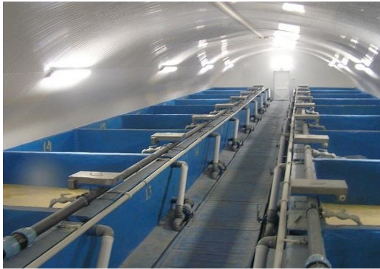
Рис. 9. Установка замкненого водопостачання (УЗВ) при вирощуванні каналъного сома [3]
