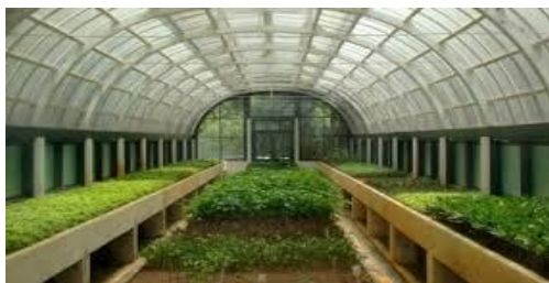
Рис. 8.1.1. Каркасна теплиця з полікарбонату
