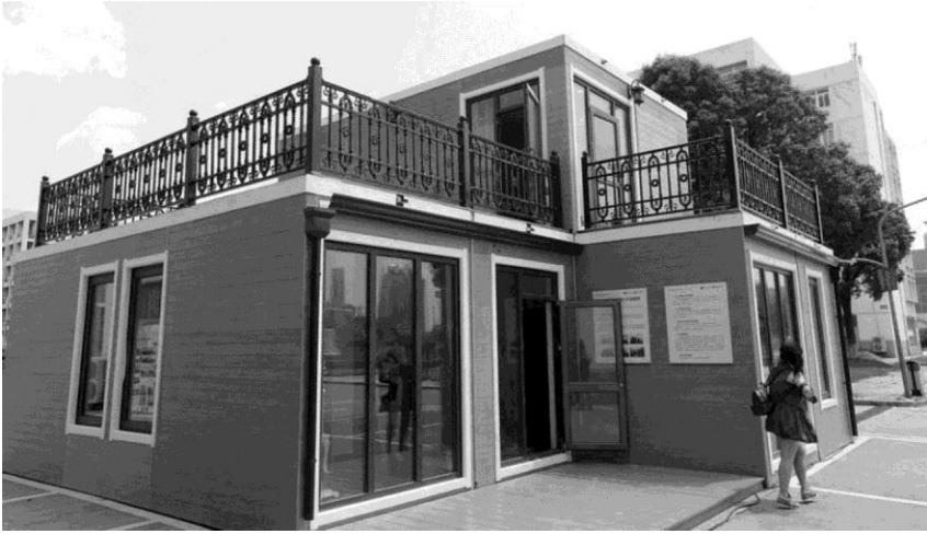
Рис. 7. Загальний вигляд будинку зведеного компанією ZhuoDa
